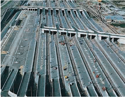
Terminal del Túnel del Canal de la Mancha (Reino Unido)
